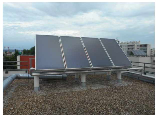
Figure 2 : Capteurs solaires thermiques « plans »
